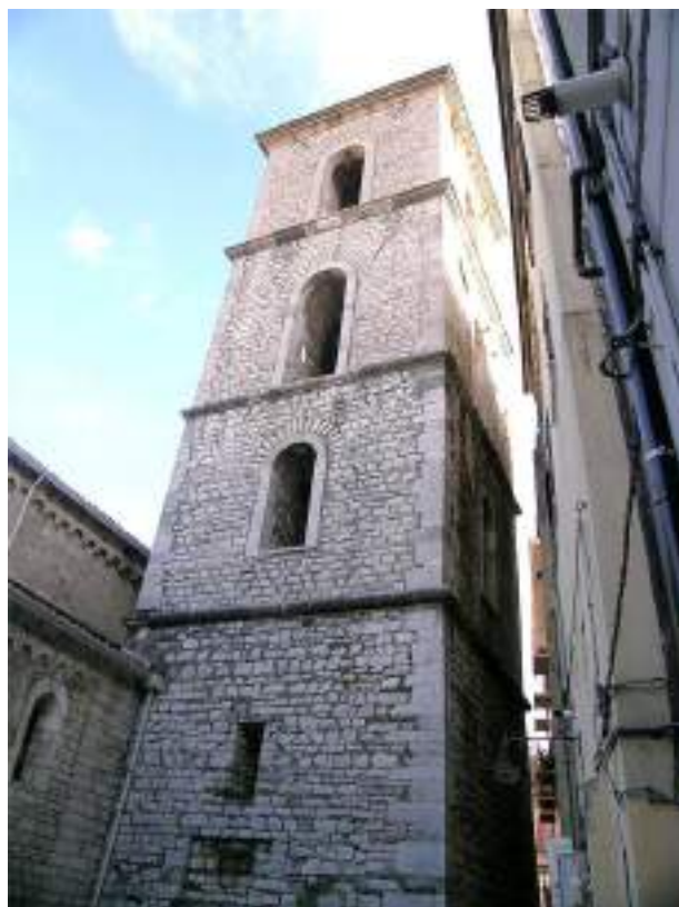
Il campanile addossato alla parete laterale destra della chiesa
