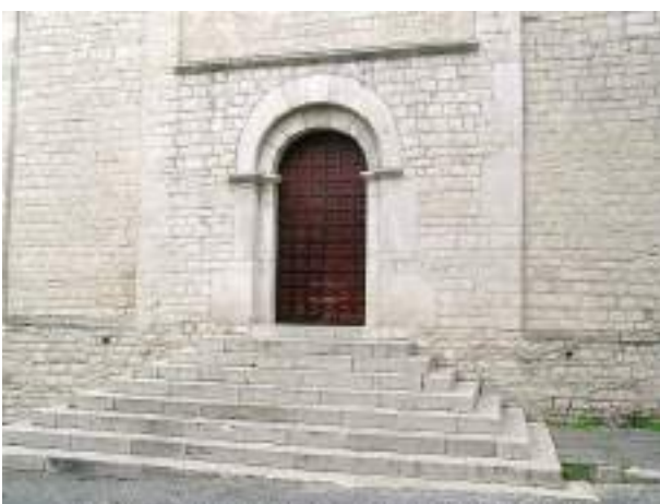
Il portale dell'ingresso principale e la scala a U
