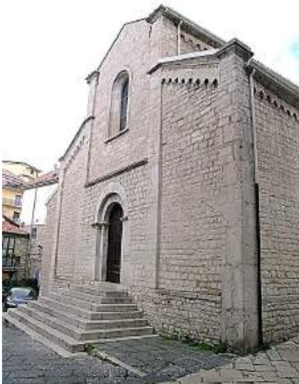
La facciata principale suddivisa da due lesene che riquadrano la parte centrale più alta corrispondente alla navata centrale
