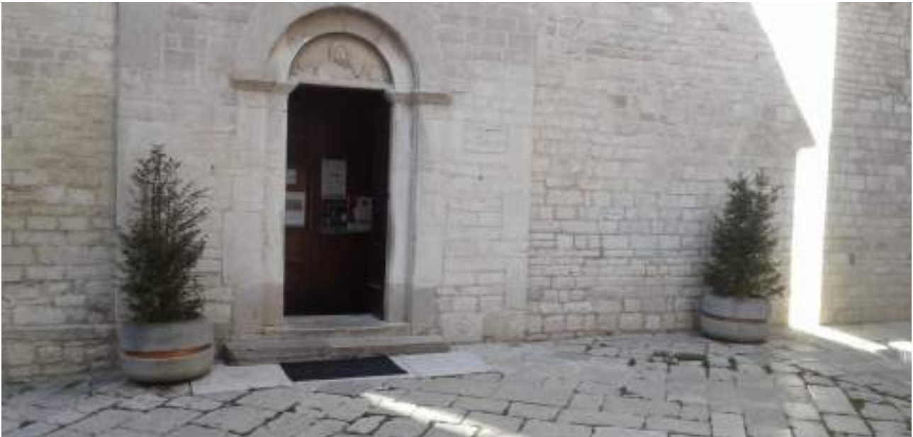
L'ingresso laterale presenta due gradini esterni a salire e due interni a scendere conseguenza dell'improprio alzamento della quota pavimentale effettuata in epoca moderna e del ripristino dell'originaria quota medioevale effettuata nei lavori di restauro degl'anni '80
