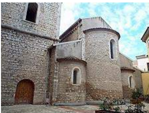
La terminazione trilobata della chiesa e l'ingresso al camdel panile
