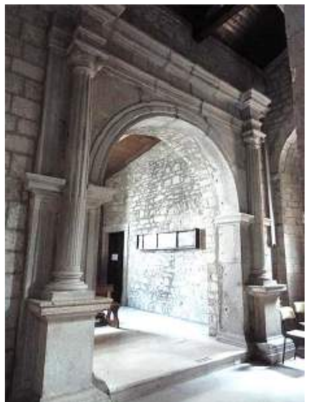
La quinta arcata costituita da una raffinata composizione architettonica in perfetto stile tuscanico. Sulla parete si nota la pregevole tavola di Cristo e i dodici Apostoli
