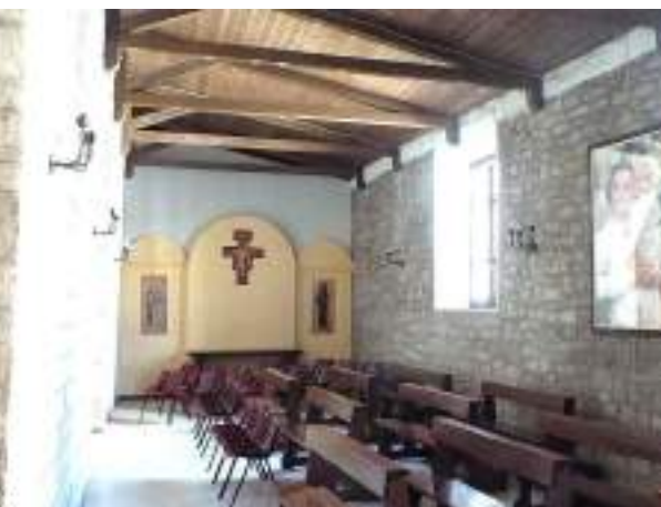
Le attuali pannellature sulla parete di fondo della "quarta navata" da ristrutturare
