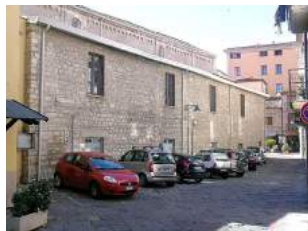
La facciata della "quarta navata" è il risultato dei lavori 1848
