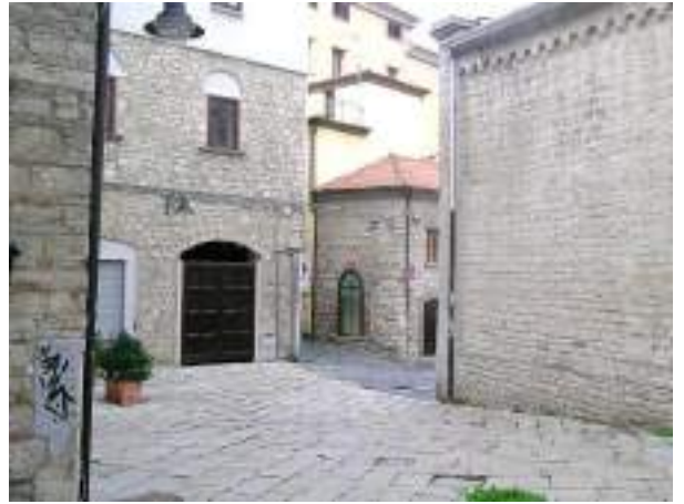
L'ingresso in piazzetta da via Rosica con le due distinte pavimentazioni ( pietra calcarea bianca del largo S. Michele e pietra vulcanica grigia di via Rosica )
